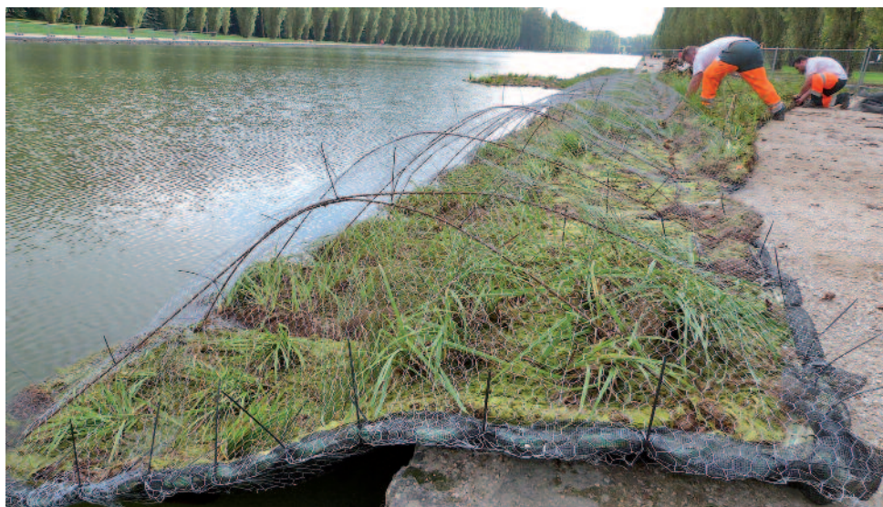
Préparation de l'îlot végétalisé du nord du Grand Canal, Sceaux. Le grillage temporaire protège les jeunes plants du broutage des canards. (O Bouviala, CG92)
