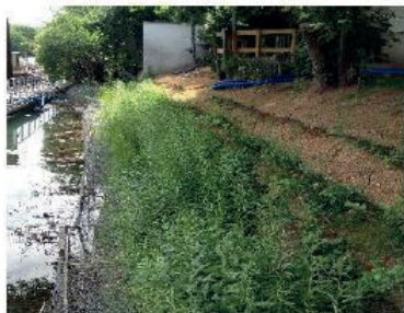
Avant/Après travaux de restauration des berges de l'île Saint-Germain à Issy-les-Moulineaux © Espaces
