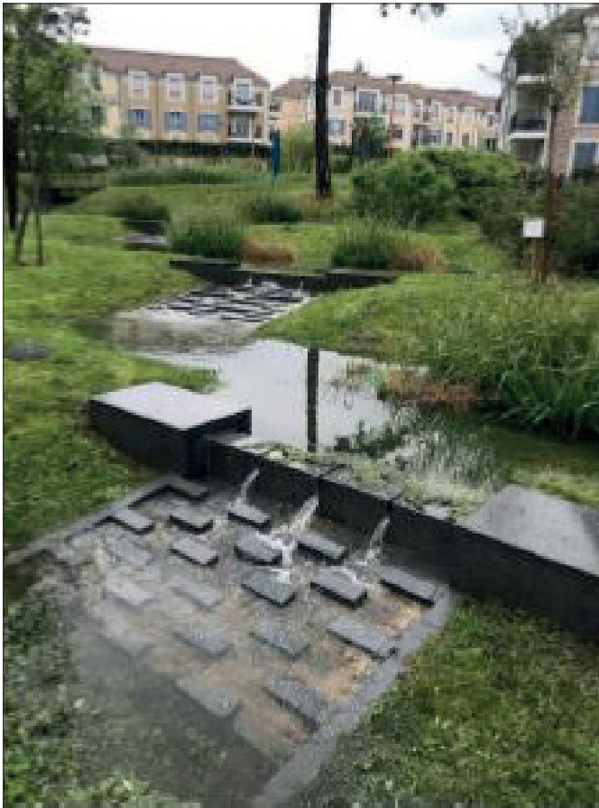
Jardin des eaux à Fourqueux © Daniel LEVEL
