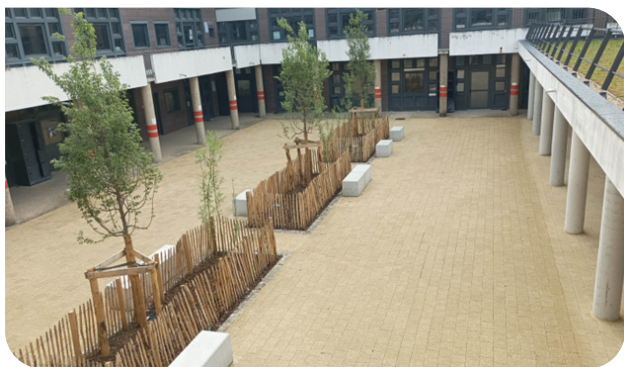
Cour centrale du collège Paul-Éluard à Nanterre - © CD92
