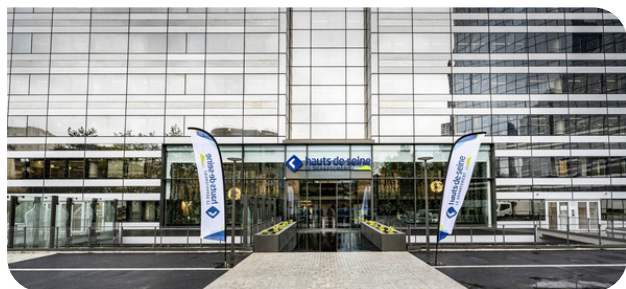
Entrée de l'ARC - ©CD92
