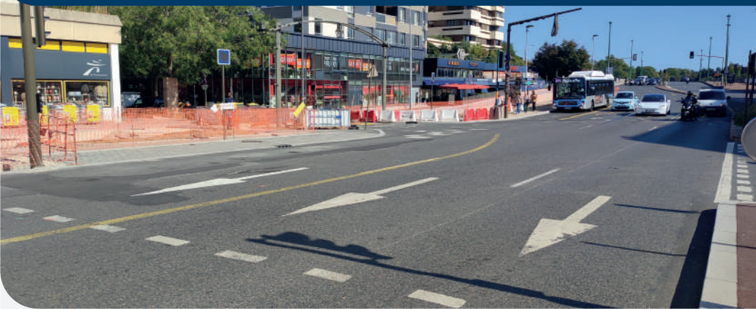
Travaux sur la chaussée côté nord du boulevard Henri-Sellier à Suresnes - ©CD92
