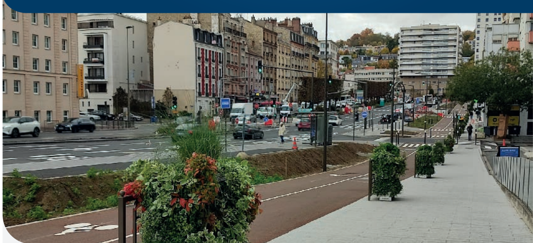
La contre-allée nord entièrement rénovée donne une plus grande place aux piétons et cyclistes. ©CD92
