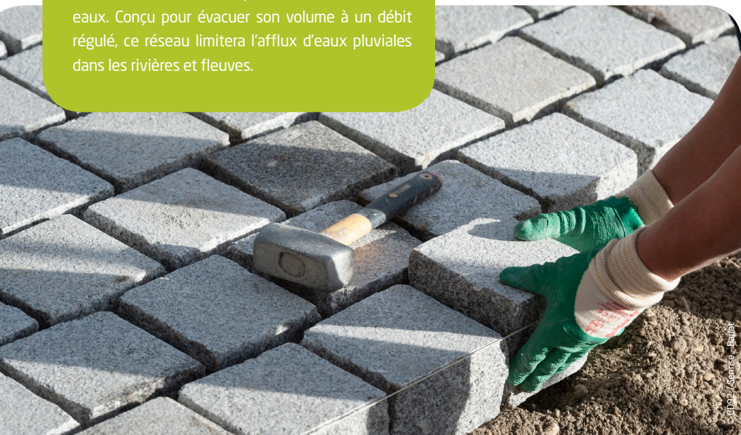
Pose des pavés granit
