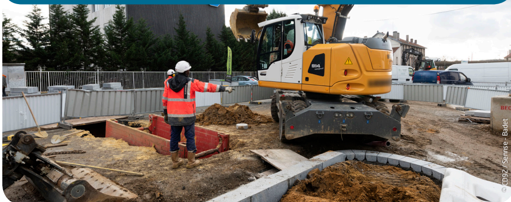
Réalisation de tranchées pour les réseaux d'assainissement
