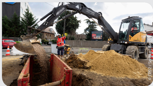
Réalisation de tranchées pour les réseaux d'assainissement
