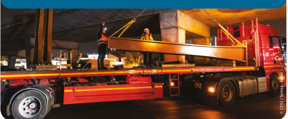
Pose de la structure métallique sur le carrefour du Petit Clamart
