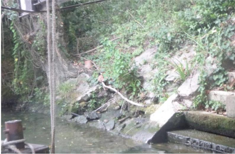
Le perré maçonné est fortement dégradé, la végétation herbacée mais aussi arbustive et des arbres sont implantés dans cet ouvrage de protection, accélérant sa dégradation.
