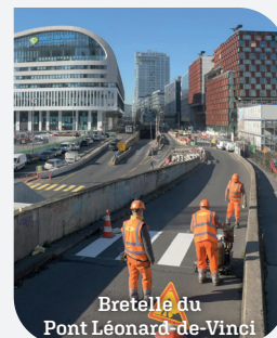
Bretelle du Pont Léonard-de-Vinci
