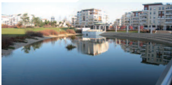
Bassin de régulation paysagé - Bois-Colombes
