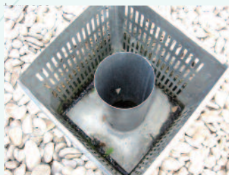
Dispositif de régulation sur toiture
