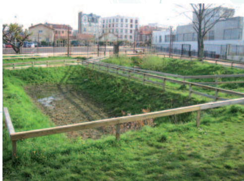
Bassin végétalisé de dépollution et d'infiltration - Nanterre
