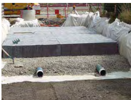
► Pose de blocs alvéolaires (structures non visitables et non curables)
