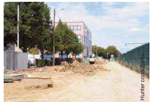
► création d'un bassin de rétention des eaux pluviales et rénovation de la chaussée - Châtillon RD63
