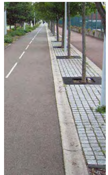
► Zones d'infiltration (plantations et pavés poreux) - Avenue de la République - Nanterre
