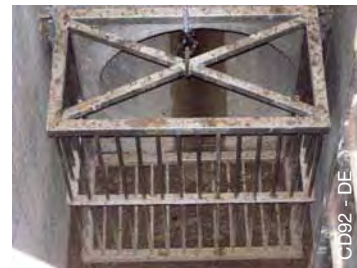
► Dégrilleur - Boulodrome - La Garenne-Colombes
