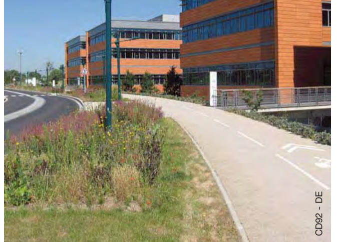
► Noue plantée - Zac des Louvresses - Gennevilliers
