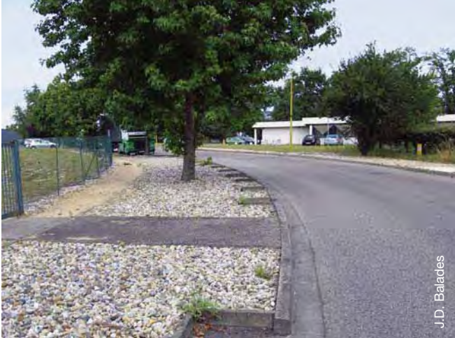
► Tranchée drainante - Grande lande - Draguignan
