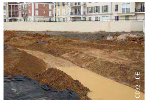
► Géomembrane - Cité jardin - Le Plessis-Robinson
