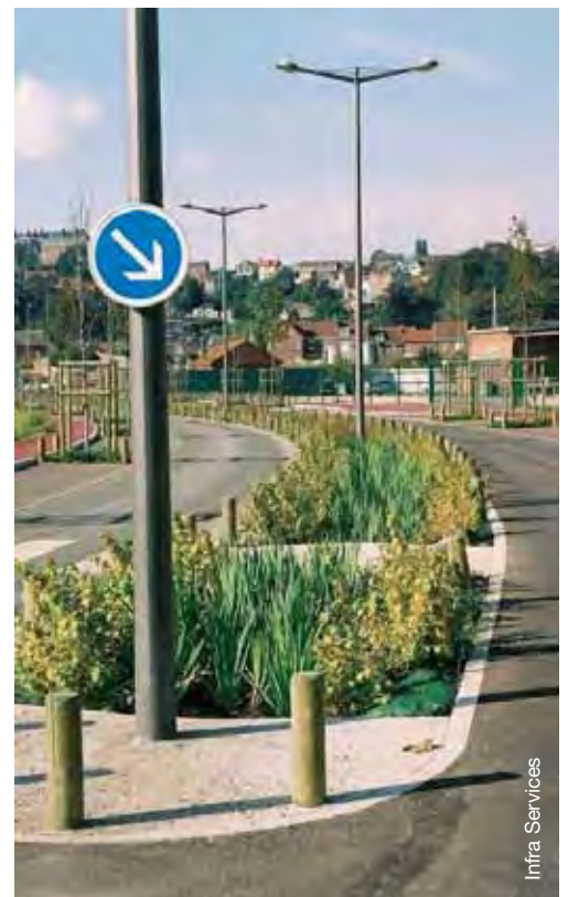
► noue végétalisée intégrée au terre-plein central d'une voirie - Dieppe
