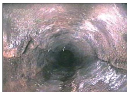
Dégradation du réseau liée à un rejet non conforme
