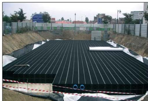
Construction d'un ouvrage de régulation et réutilisation des eaux pluviales à Asnières
