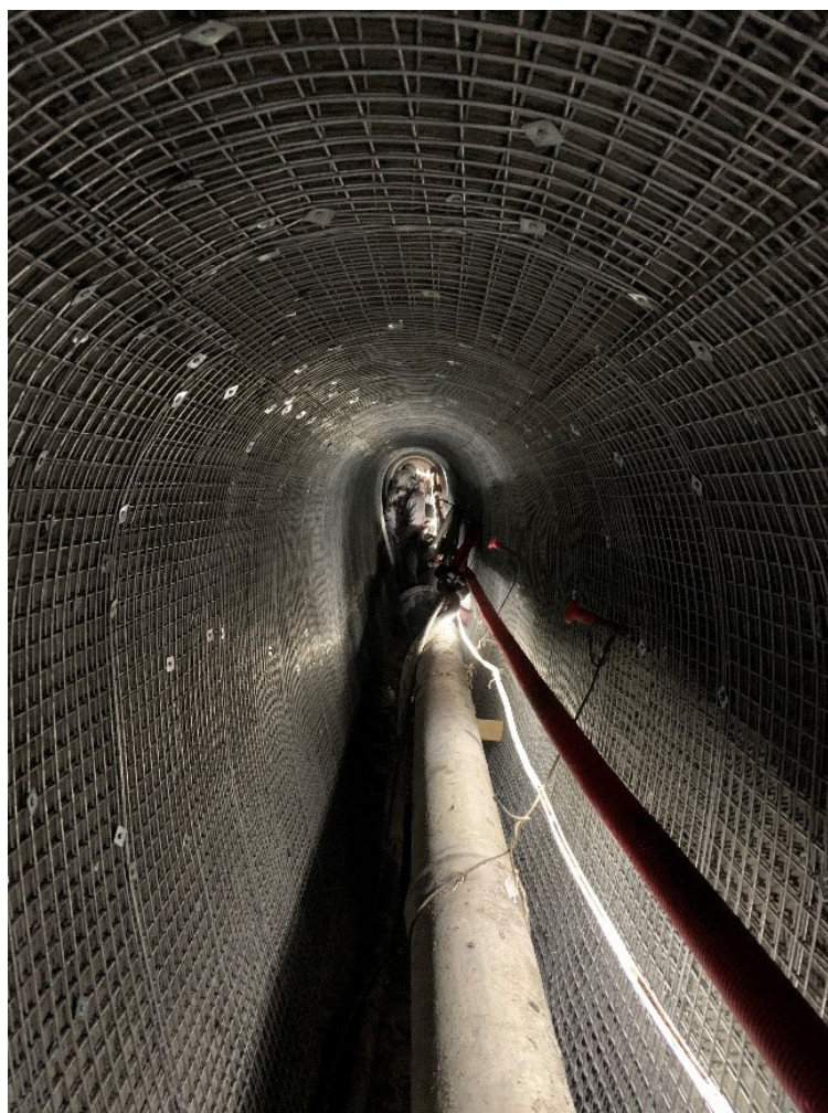
Figure 23 : Travaux de renforcement du collecteur Avenue du Colonel Fabien
