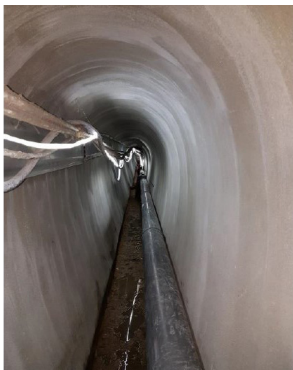
Figure 25 : Travaux de réhabilitation par béton projeté bd de la République à La Garenne Colombes
