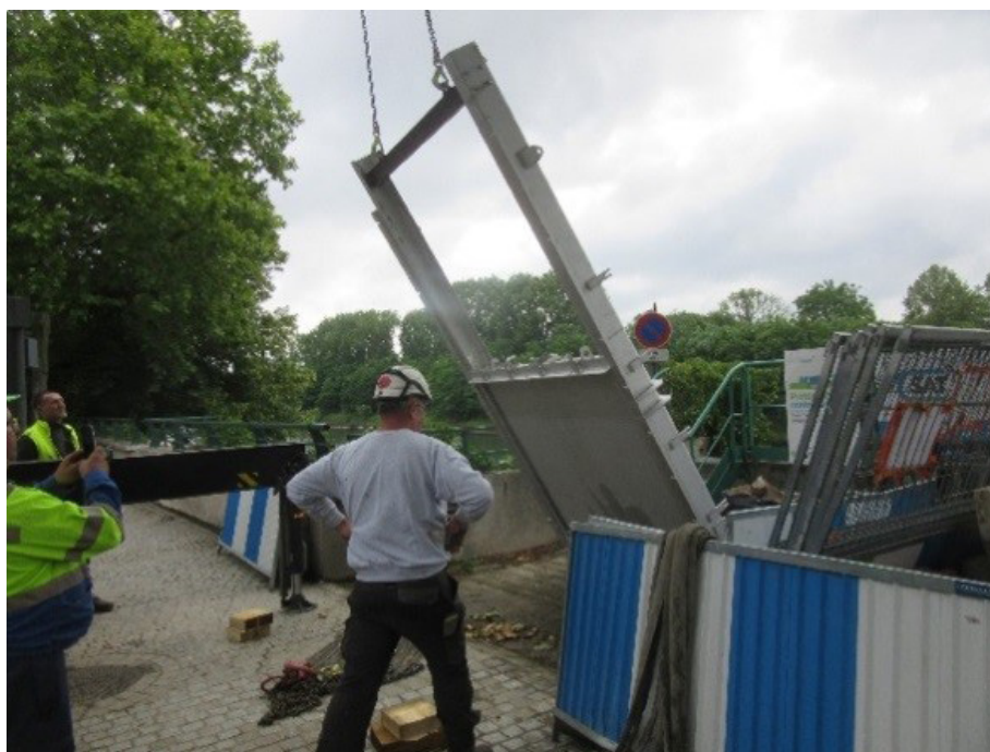
Figure 28 : Livraison de la vanne de crue V22
