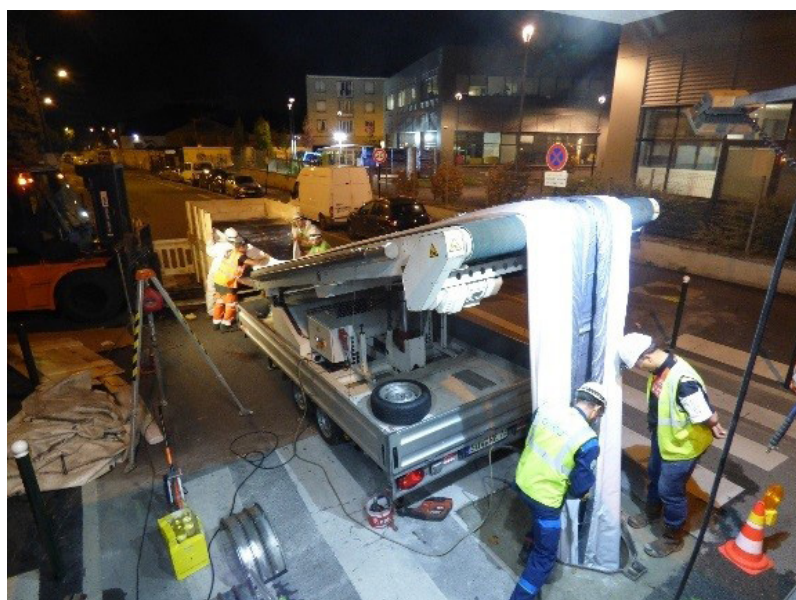
Figure 21 : Travaux de chemisage du collecteur AV A. Briand à Bagneux
