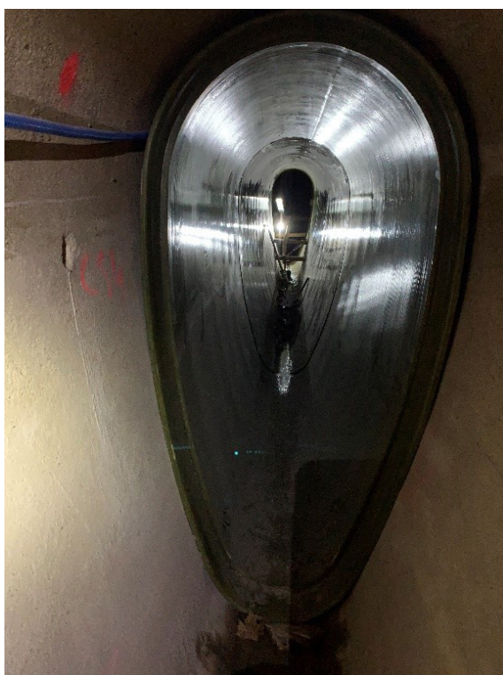
Figure 24 : Travaux de pose de coques dans le collecteur rue Roguet à Clichy
