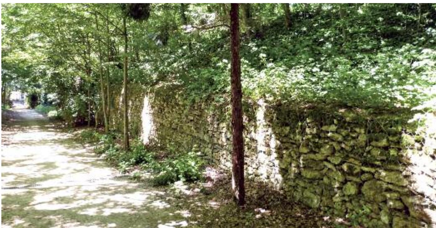
Mur -ancien enclos des Feuillants- longeant l'allée descendante vers l'entrée Paul Rivet. Une partie du mur est consolidée par un système de gabions (cage préformée enfermant les pierres d'origine prises sur le site).
