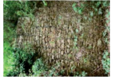
mur de soutènement en partie refait avec des gabions
