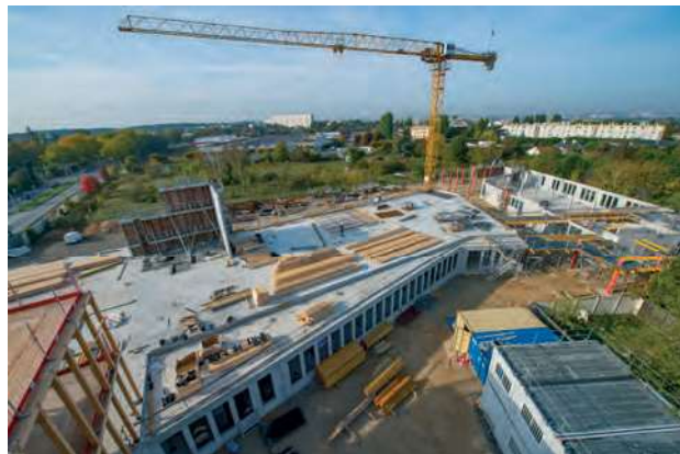
Chantier du futur collège Samuel-Paty ©Michael Lumbroso
