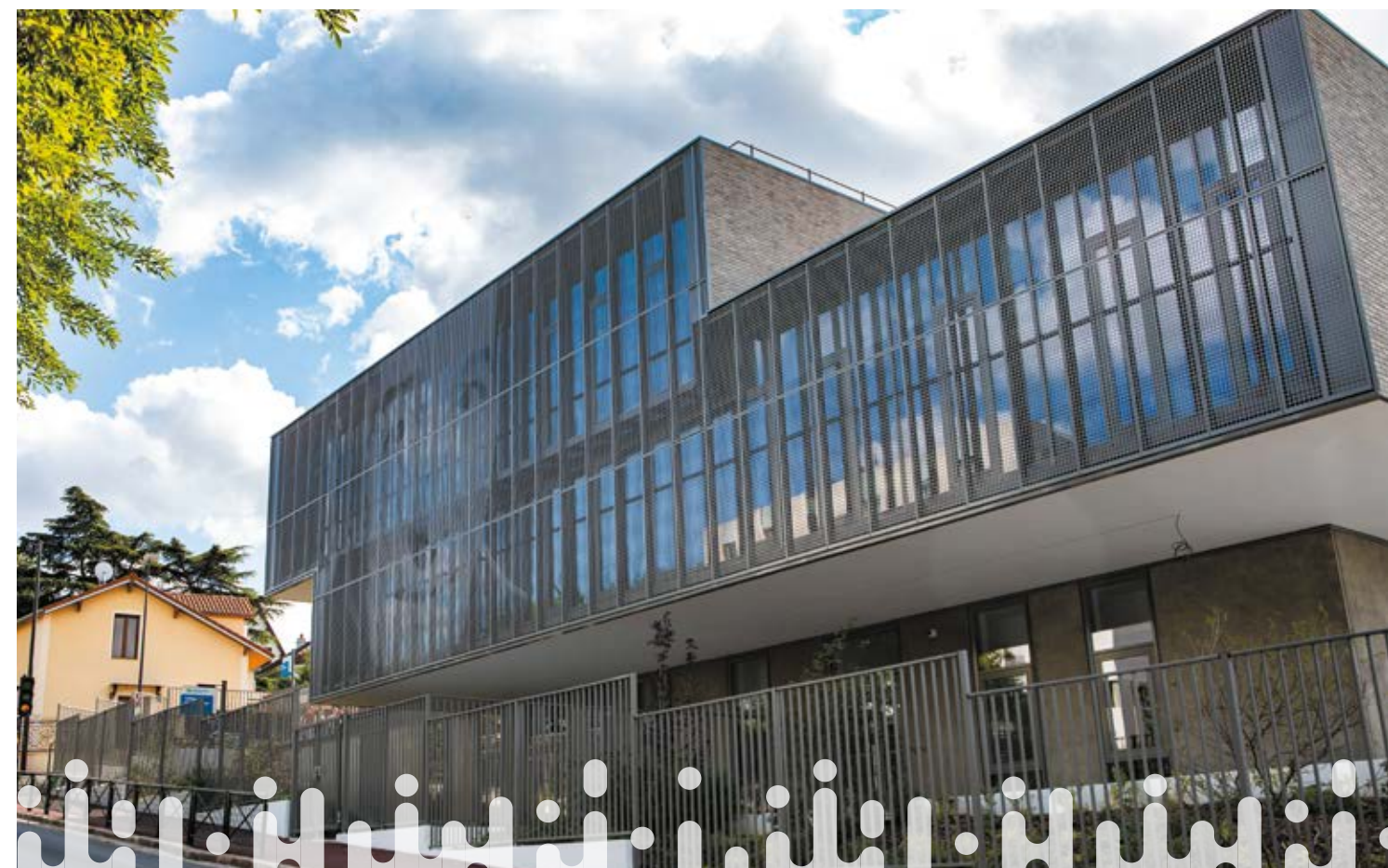
Collège Marcel-Pagnol à Rueil-Malmaison ouvert à la rentrée de septembre 2019
