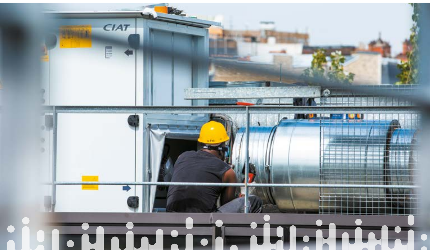
Travaux de rénovation énergétique au collège Théophile-Gautier à Neuilly-sur-Seine
