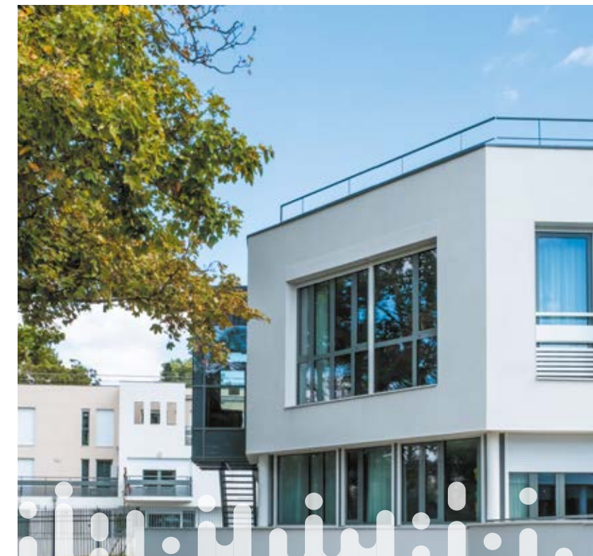
Programme de 25 logements locatifs sociaux neufs situés 7 bis rue Yves-Cariou à Marnes-la-Coquette, septembre 2019.
