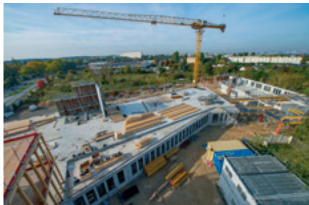
Chantier du futur collège Samuel-Paty ©Michael Lumbroso
