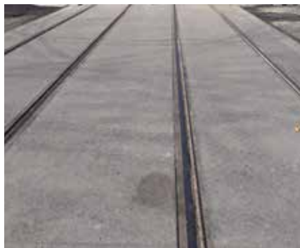
📍 Béton en section courante © Cyril Badet
