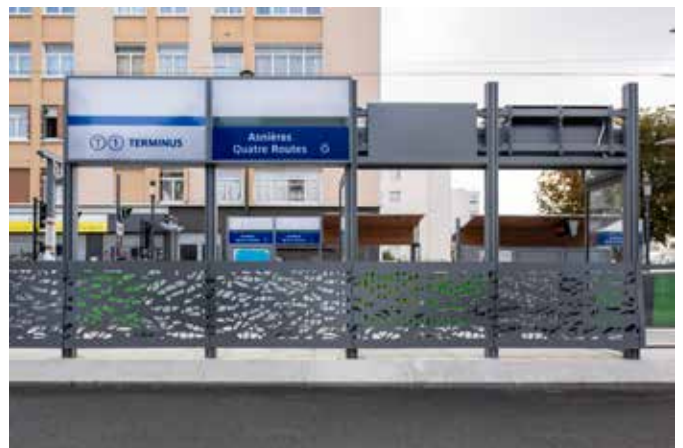
La nouvelle station Asnières Quatre Routes à Asnières-sur-Seine © Cyril Badet
