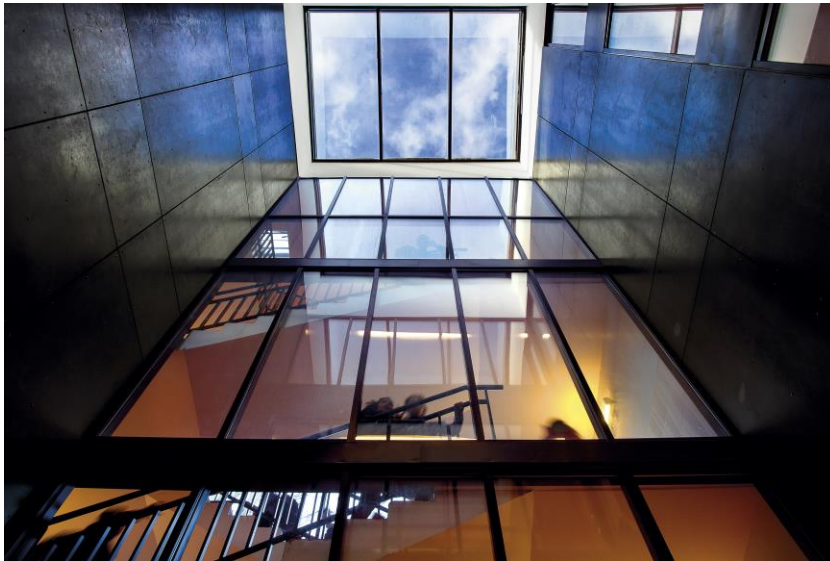
Puits de Lumière – Collège Paul-Eluard, Châtillon ©CD92/Julia Brechler
