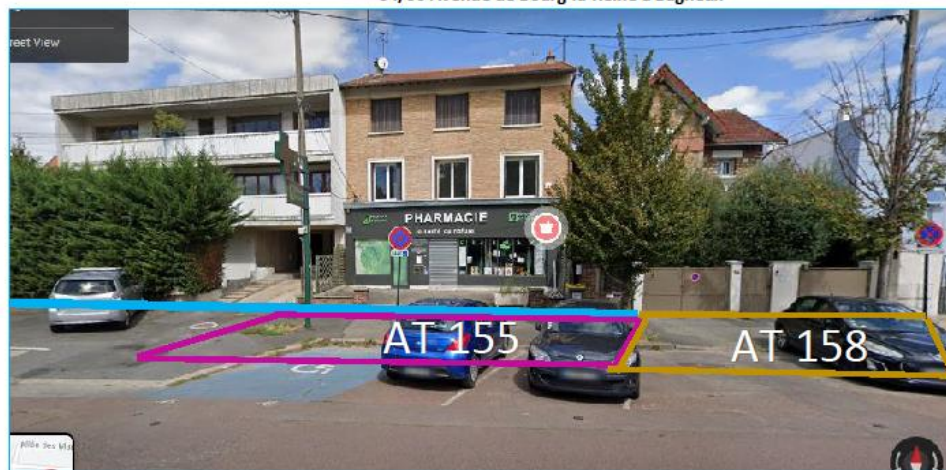
Parcelles AT 155 et AT 158 54/56 Avenue de Bourg-la-Reine à Bagneux
