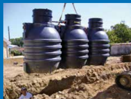
Micro-station d'épuration en cours d'installation
