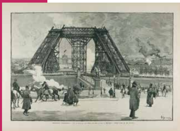
La Tour Eiffel en construction, Archives départementales des Hauts-de-Seine, 397PEG62
